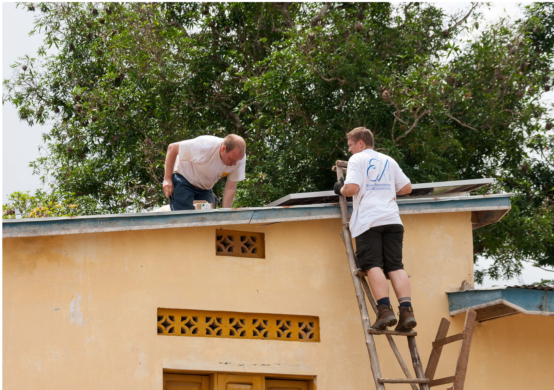
2016: plaatsing zonnepanelen (met Energie Assistance)
