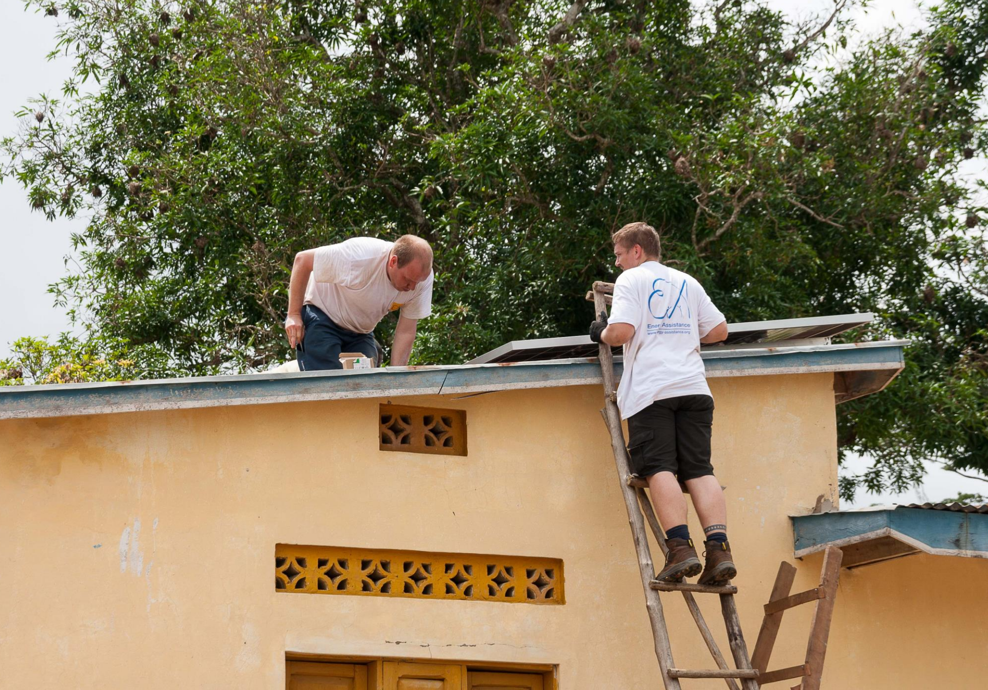
2016: plaatsing zonnepanelen (met Energie Assistance)
