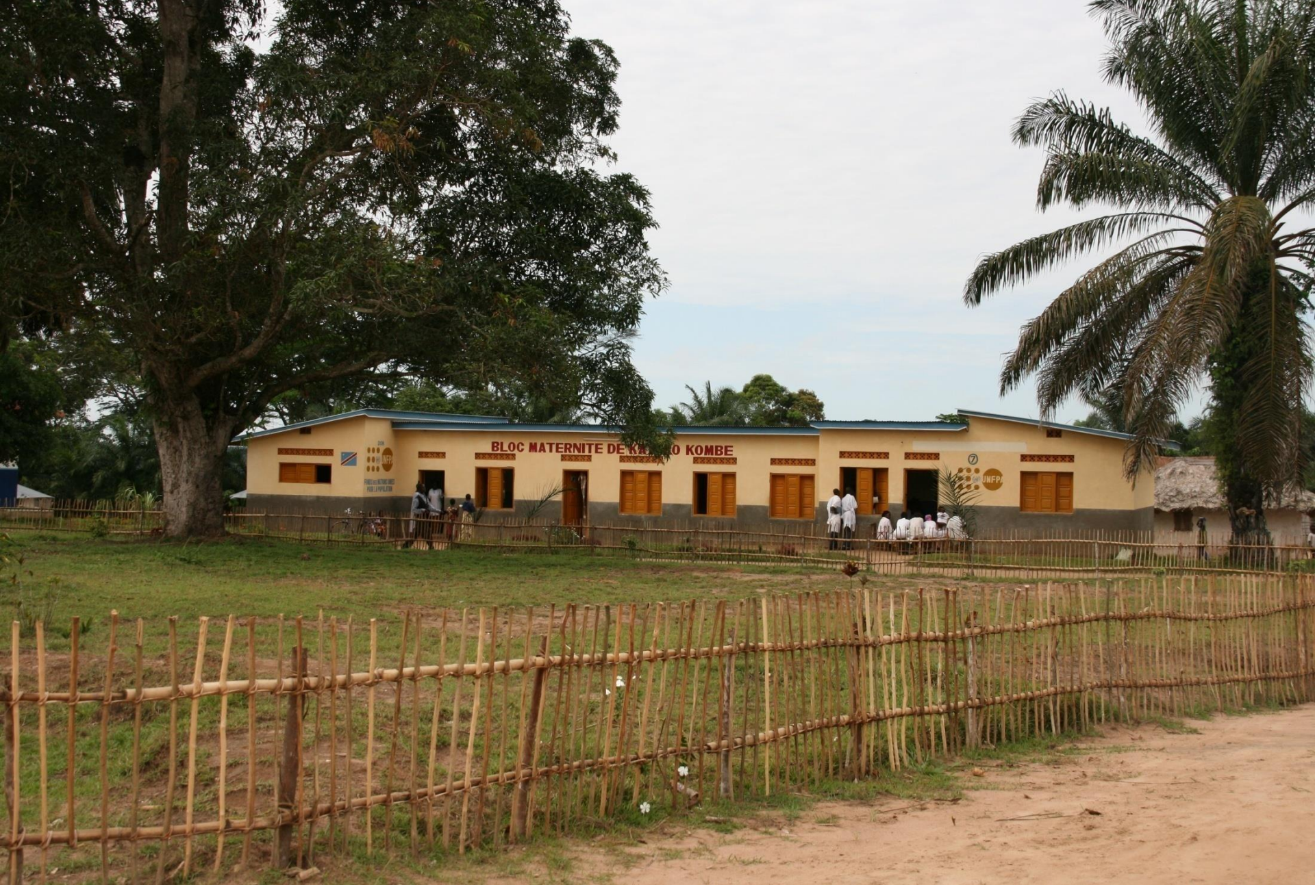
2008: nieuw moederhuis (gebouwd door UNFPA)
