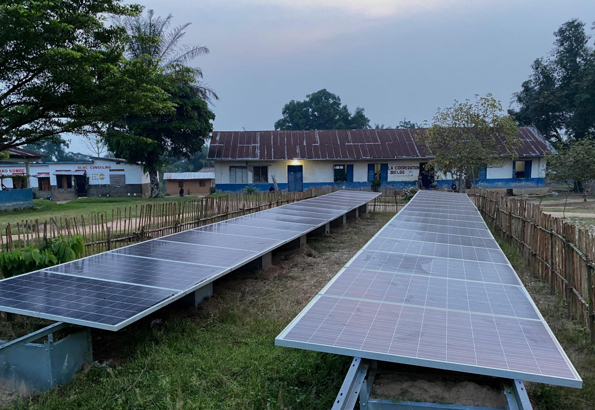
uitbreiding zonnepaneel installatie
