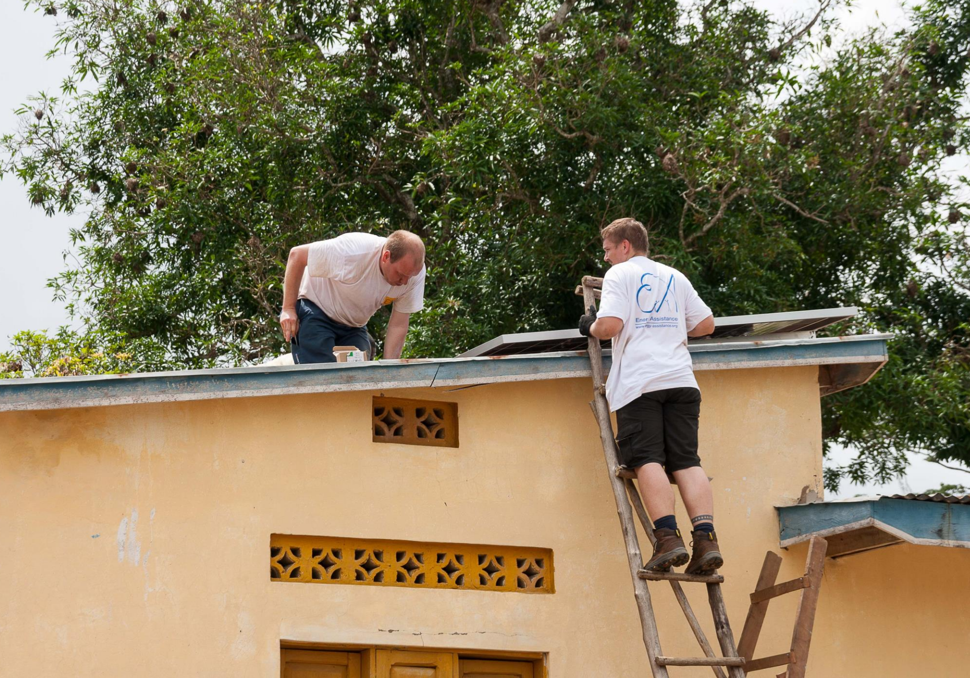
2016: plaatsing zonnepanelen (ism Energie Assistance)
